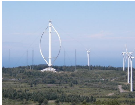
Figure 3 : Eolienne Darrieus au sein du parc Éole – Source : futura-sciences.com
